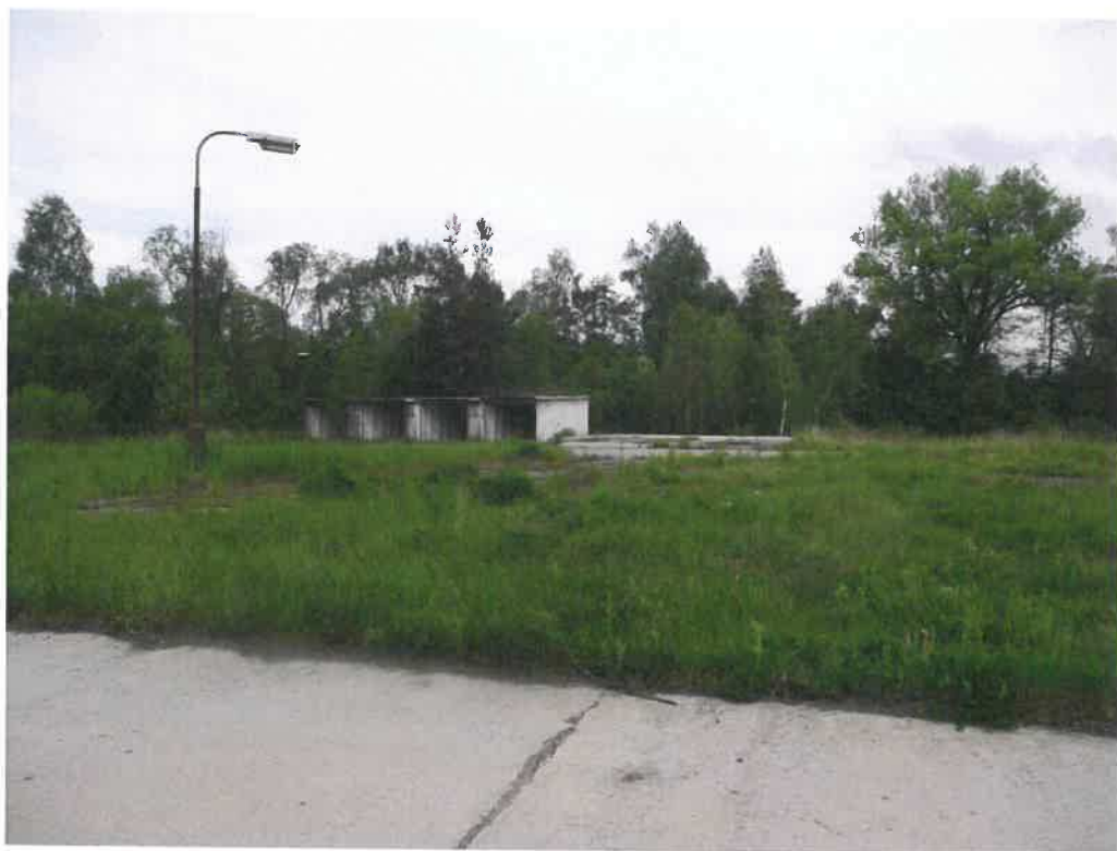
OBJEKT SO.11 - budovy na pozemku p.č. 975, 976, 977, 978, 979 – bývalé garáže
