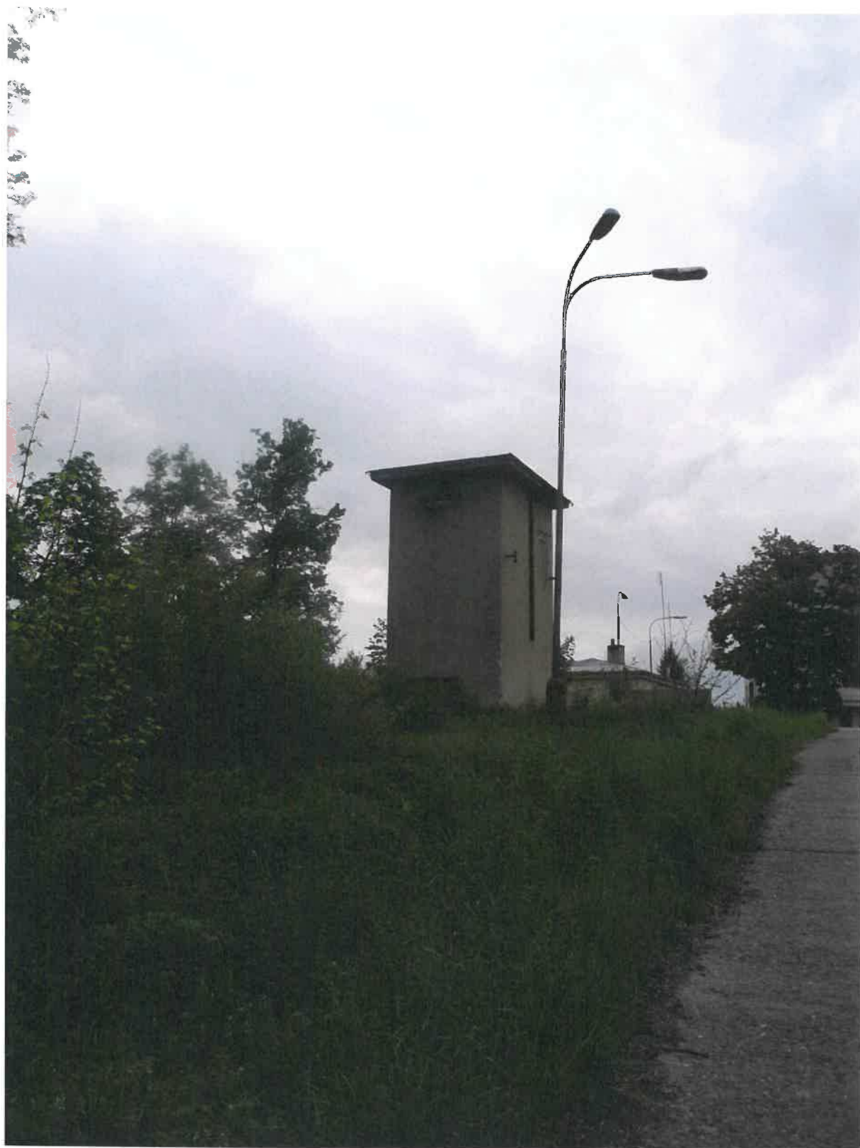
Objekt na pozemku p.č. st. 581 - bývalá trafostanice
