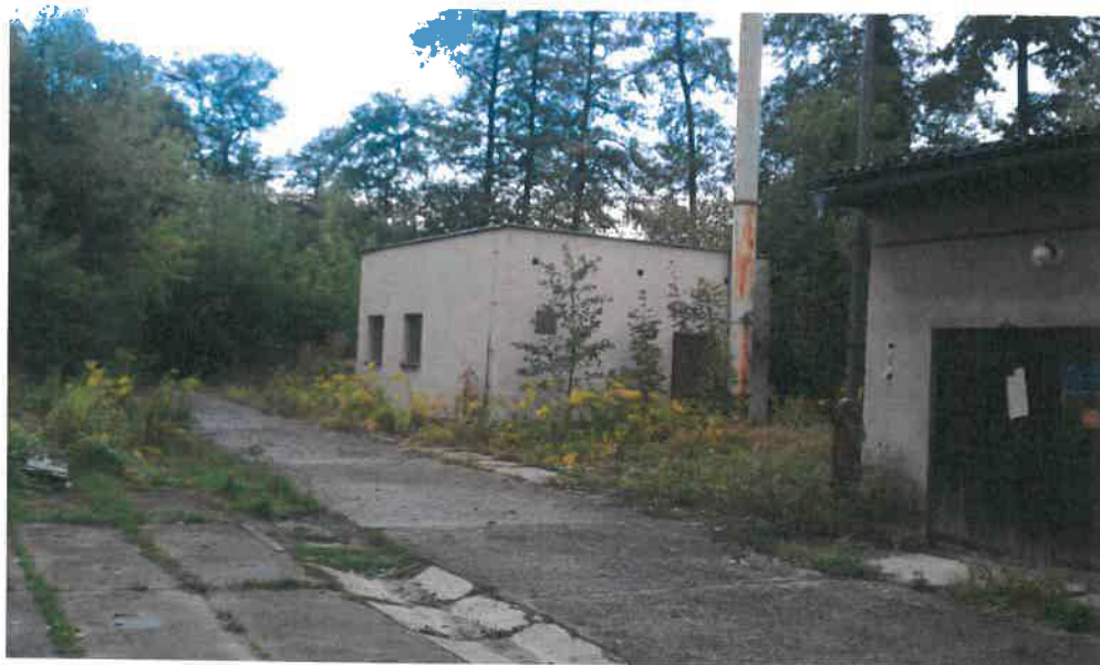
OBJEKT SO.06 - budova na pozemku p.č. st. 572 – čistírna odpadních vod
